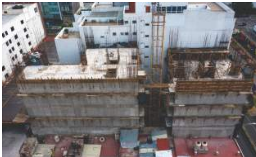
CONSTRUCCIÓN de un edificio en la alcaldía Cuauhtémoc, en foto de archivo.
