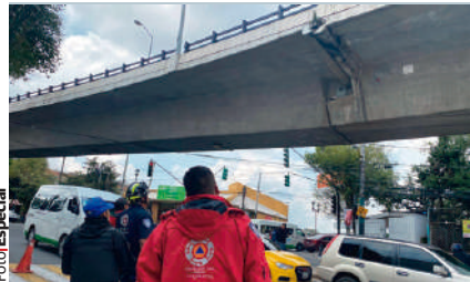
Foto Especial PERSONAL de Protección Civil de Cuajimalpa revisa el puente El Yaqui, ayer.
