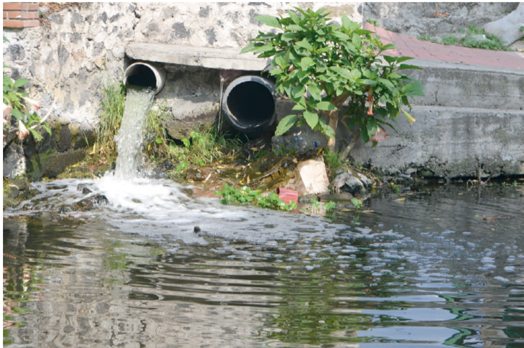
DOS TUBOS de drenaje desembocan en uno de los canales, como se aprecia en esta imagen tomada ayer.
