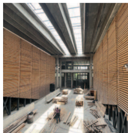
TRABAJADORES realizando obras en el nuevo espacio dedicado al cine.
