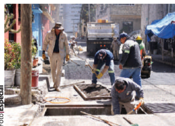
TRABAJADORES de Huixquilucan, ayer, en las labores de limpieza.
