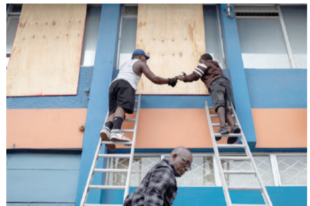
TRABAJADORES de Jamaica protegen ventanas en edificios de gobierno y puntos críticos.
