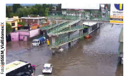
INUNDACIÓN en la avenida Nacional, en Ecatepec, Estado de México, ayer.
