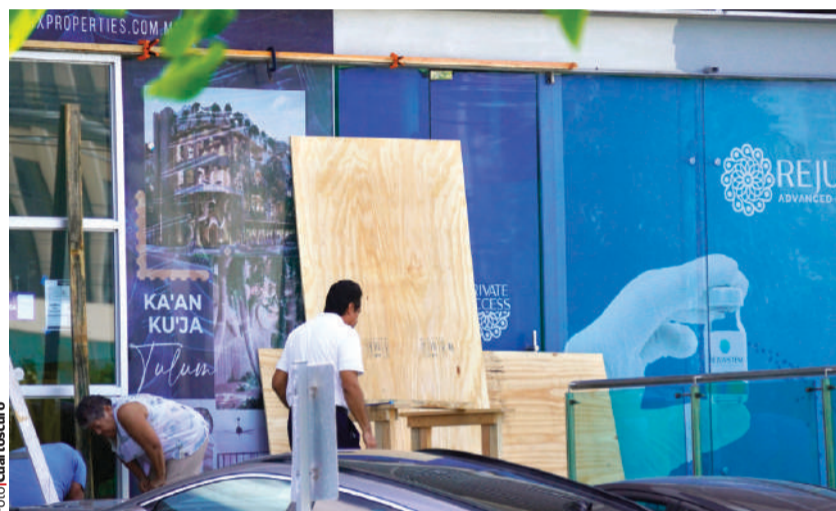
VENTANALES de algunos comercios fueron reforzados con tabloncillos de madera, ayer.
