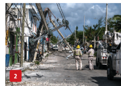
1 EN COZUMEL seguían ayer las labores de retiro de ramas caídas.
