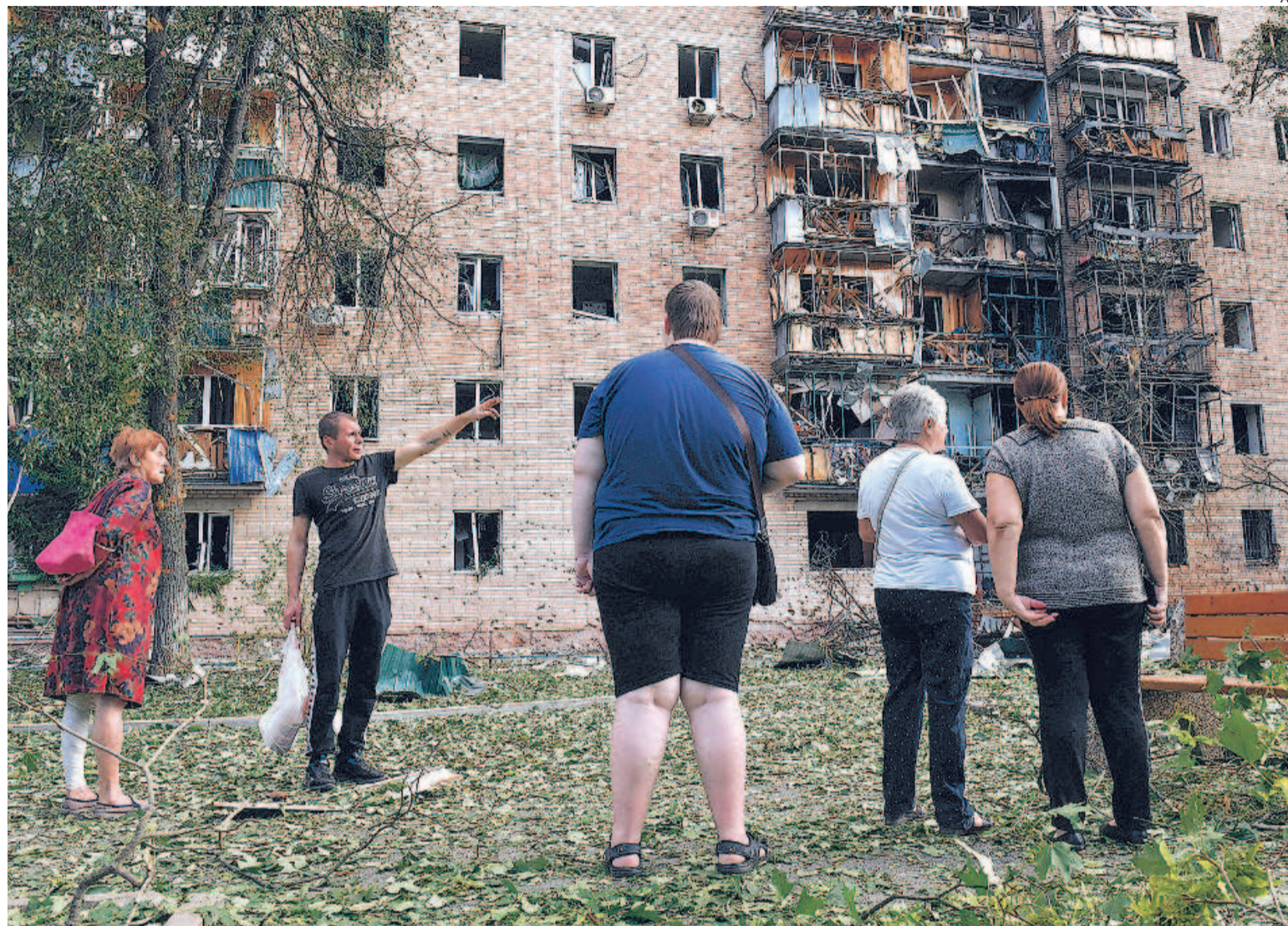
AP Vecinos observan los daños en un edificio atacado en Kursk (Rusia)
