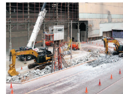
MAQUINARIA trabaja en la construcción del nuevo molino en Lagunas, ayer.
