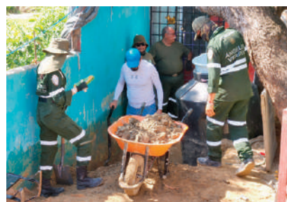
ÁNGELES VERDES, dependientes de Sectur, laboran en viviendas afectadas.
